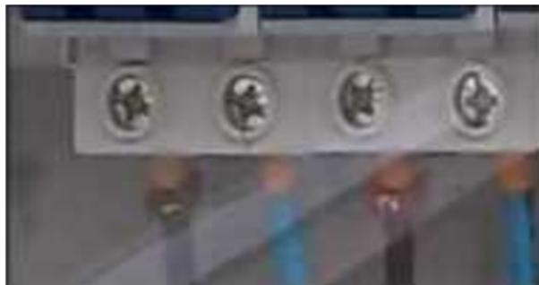
Las secciones deben ser verificadas según AEA 90364-7-771 - 771.19.2: Protección de los conductores y cables contra las corrientes de sobrecarga y cortocircuito
